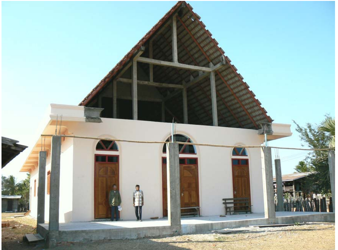
L'église de Nakham en construction
